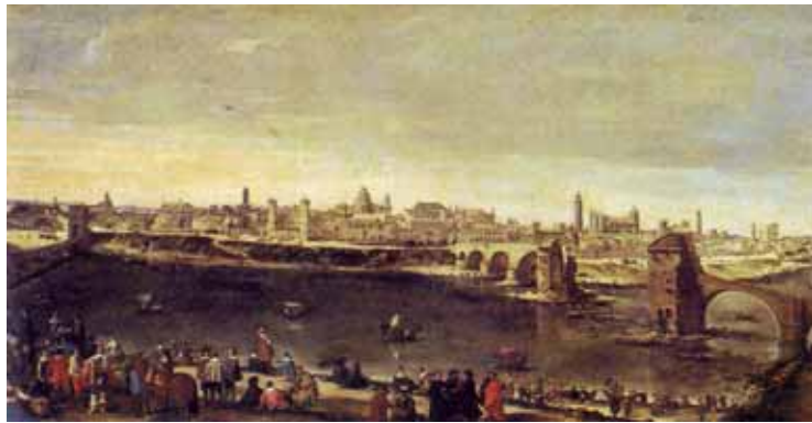
Cuadro de J. B. Martínez del Mazo, realizado en 1647 en su visita a Zaragoza, donde se aprecia el daño causado en el puente de piedra durante la riada ocurrida el 18 de febrero de 1643. Hasta 1676 no fue reparado. El cuadro se halla en el Museo del Prado (Madrid).
