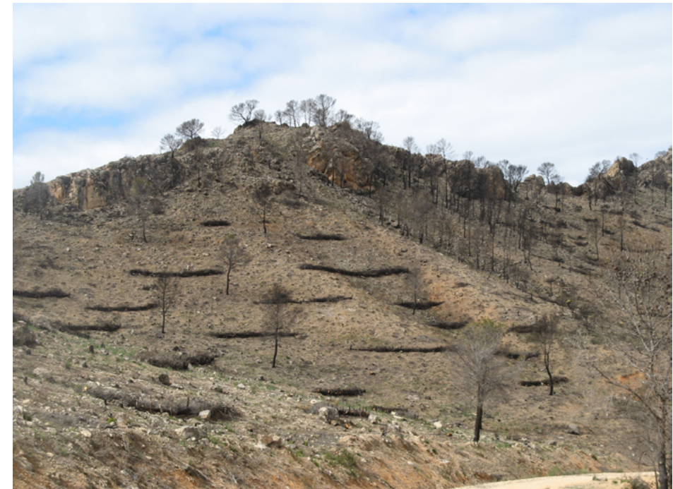
Fajinas, estructuras que se elaboran con los restos quemados del incendio para retener el suelo mientras no hay vegetación. / Manuel Esteban
